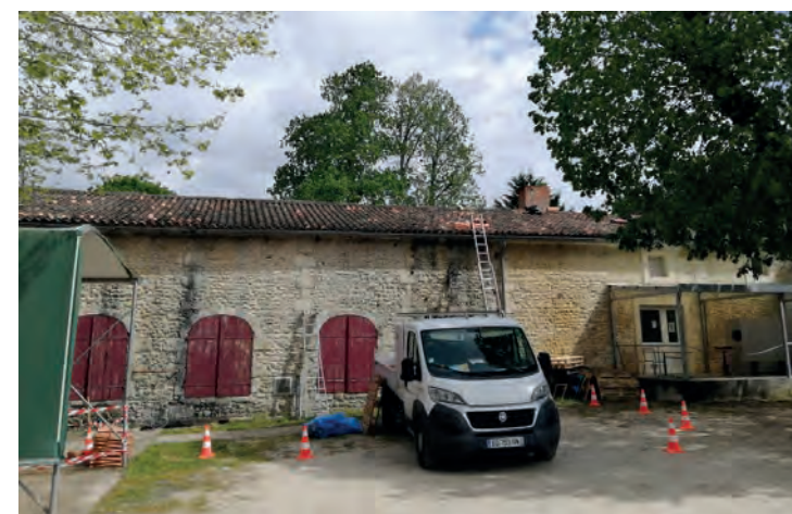
Réfection des toitures de Villambis
