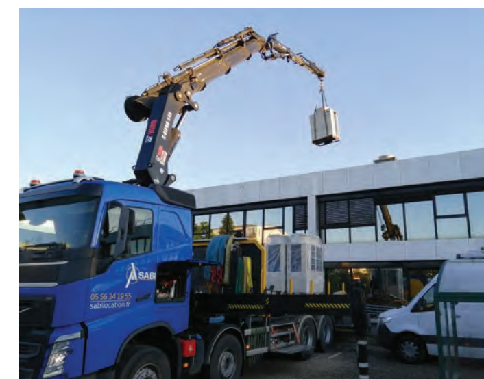
Remplacement du système de climatisation du siège
