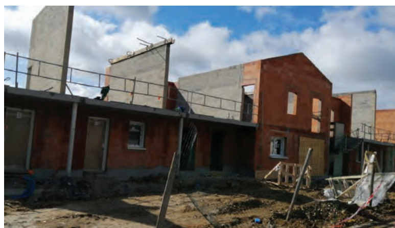
Les foyers logements de Bègles et de Saint-Denis de Pile en cours de construction
