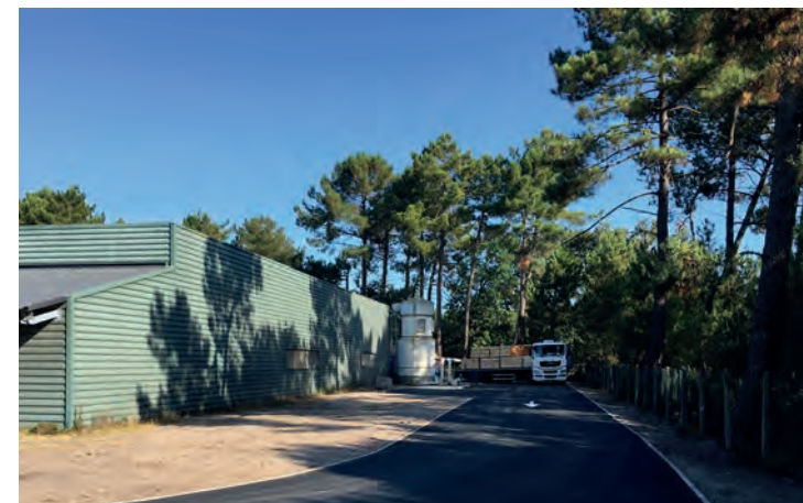
Travaux de voirie ESAT Audenge
