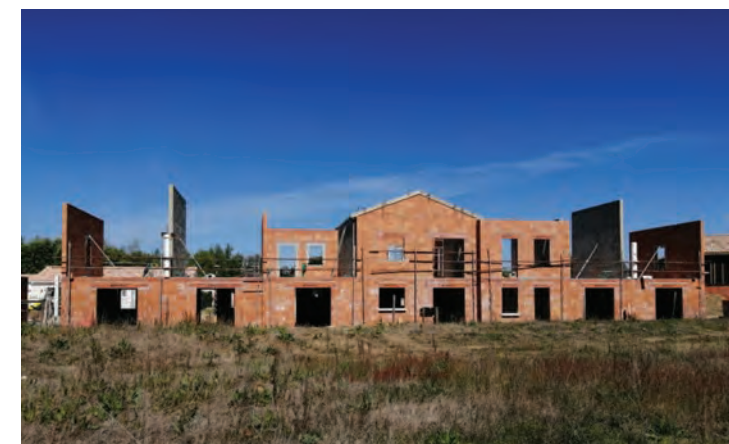
Construction du Foyer Logement de Saint-Denis de Pile
